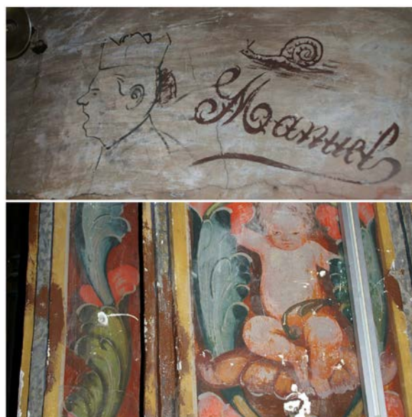
Fig 2. Grafitis antiguos, repintes con pintura plástica, arañazos, agujeros y añadidos metálicos para iluminación sobre la pintura mural de la capilla de N.ª Señora de la Capilla. Basílica Menor de San Ildefonso, Jaén. Fuente: Elaboración propia.
