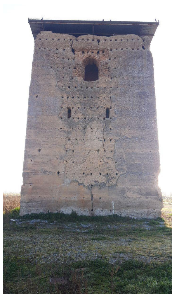
Fig. 2. Torre nazarí de Romilla. Fuente: Elaboración propia.
