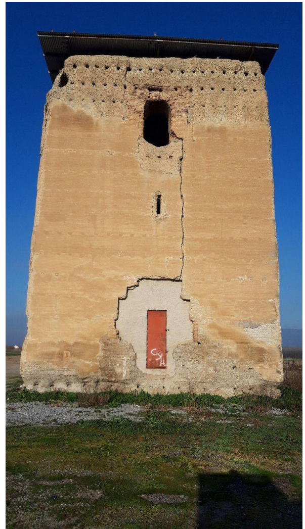
Fig. 4. Torre nazarí de Romilla. Fuente: Elaboración propia.
