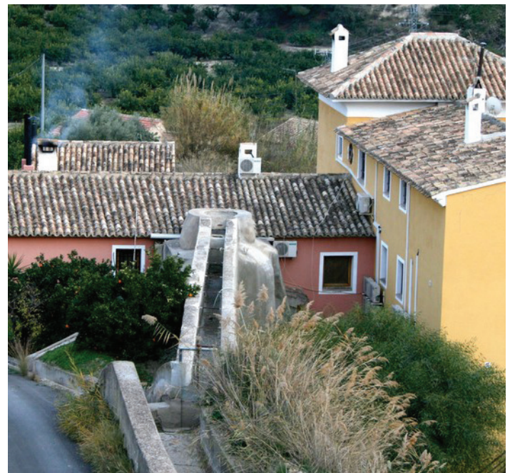
Fig.2. Vista parcial del molino de Felipe, donde se puede observar el cubo, el canal de conducción hacia él, y parte del recorrido de la Acequia Mayor.
