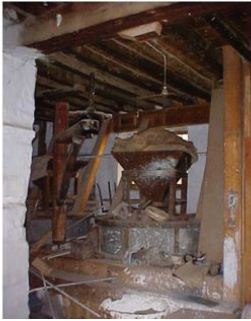
Fig. 2. Molino antes de su restauración . Fotografía. 2014. San Pablo de la Compañía de Jesús . Molvizar. Granada.
