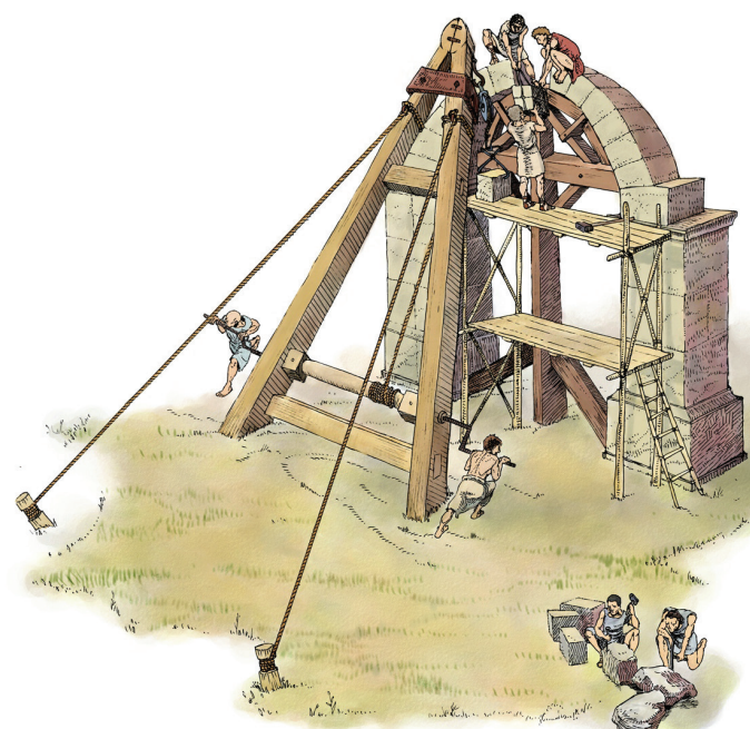
Fig. 4. Proceso de construcción del arco romano de Cabanes. Ofitesc. 2014.
