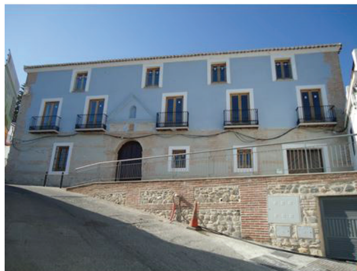
Fig. 1. Fachada principal . Fotografía. 2014. San Pablo de la Compañía de
