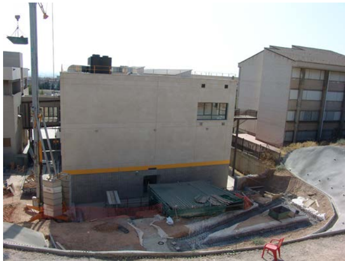
Fig. 5. Trabajos de construcción del edificio anexo, exterior.
