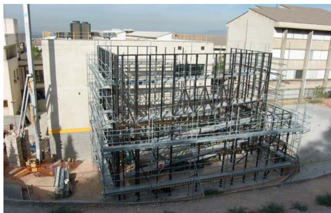
Fig. 6. Trabajos de construcción del edificio anexo, exterior.
