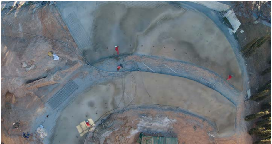
Fig. 10. Vista de los trabajos de construcción de la berma y muro de contención localizado.
