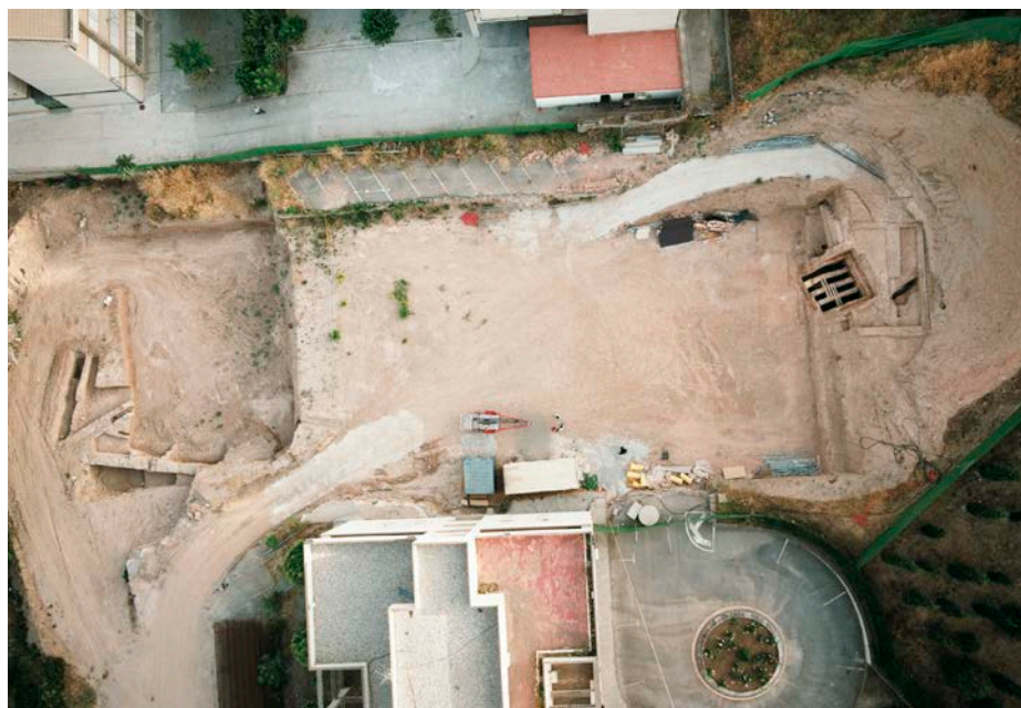
Fig. 1. Vista aérea del cajeadado del edificio y la excavación arqueológica.
