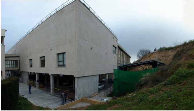
Fig. 4. Trabajos de construcción del edificio anexo, exterior.
