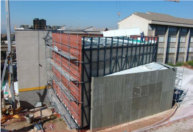
Fig. 7. Trabajos de construcción del edificio anexo, exterior.
