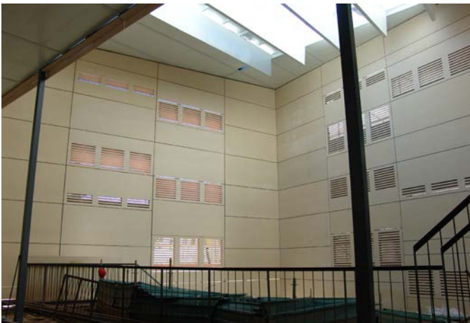
Fig. 9. Trabajos de construcción del edificio anexo, exterior.
