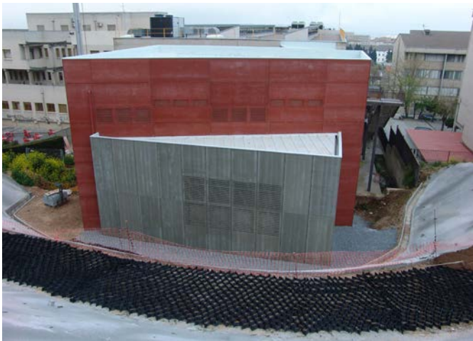
Fig. 8. Trabajos de construcción del edificio anexo, exterior.
